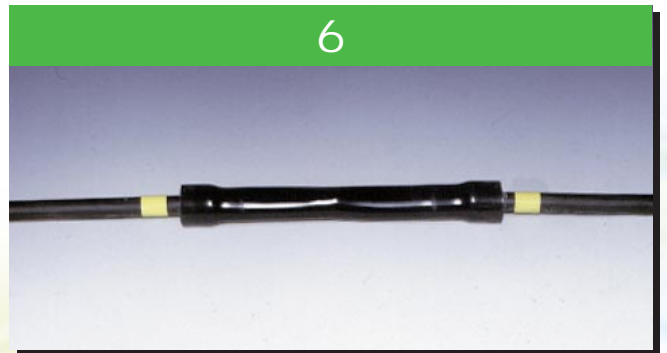
逆端のコア紐を引き抜き完了です。
