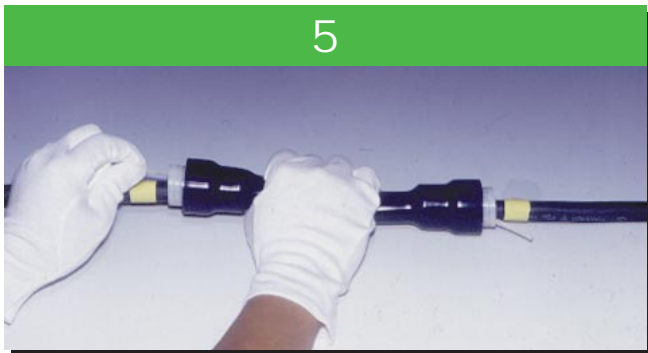
マーキング部にプルフィットチューブを合わせ、コア紐を引き抜きます。
