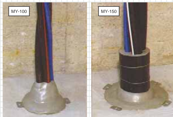
施工完成写真
