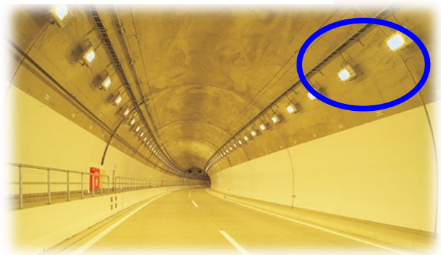
例:トンネル内照明配線
